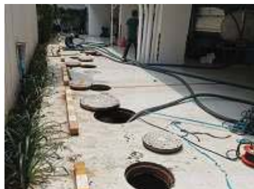
สูบล้างอุปกรณ์ในระบบบำบัดน้ำเสีย
